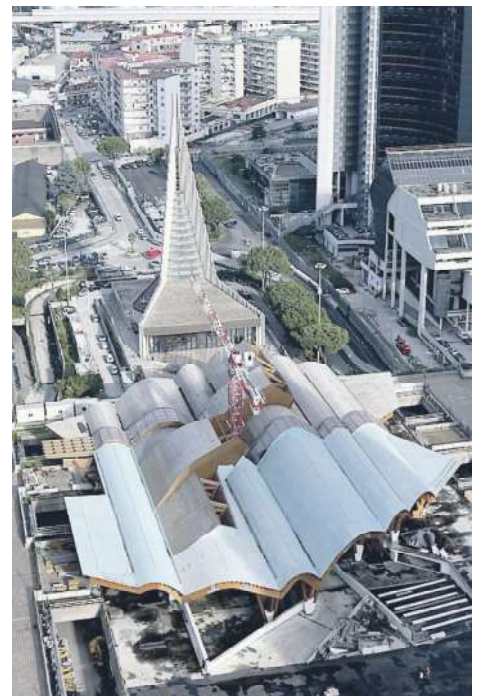
La costruenda stazione metro "Centro Direzionale vista da Torre Francesco NewFotoSud
